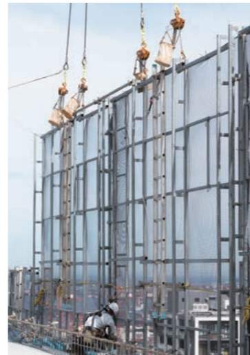
右／屋上に鉄骨造のエレベーター機械室を設置する工事が進められている。今後、太陽光発電パネルや屋上緑化が施される。 左／最上階まで躯体工事が進み、躯体外部のスライド式足場をクレーンで引き上げているところ。3.5層分の高さの足場を設け、1層分の工事が完了すると引き上げる方式。
