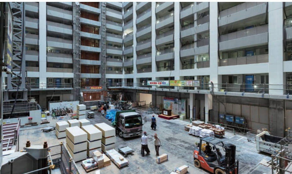
上/協力会社の責任者と話す高見所長。背後はエレベーターに向かう作業通路。安全に配慮して歩車分離し、休憩所から最短ルートに設置している。 左/建物中央吹抜け部分は内部仕上げ工事のためのヤード。外壁材、サッシ、下地・造作材、ユニットバスなど多くの資材を仕分け、荷揚げ専用の高速エレベーターでフロアへ運び込む。
