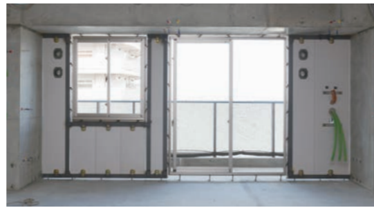
上／電気、マルチメディア、電話などの配線は用途ごとに色分けし、住戸の間取りに合わせて工場製作されたものを取り付ける。 右上／躯体工事が完了した上層階内部。柱、梁はPC工法、床はハーフPC工法。 右下／外壁にはALC版を採用。
