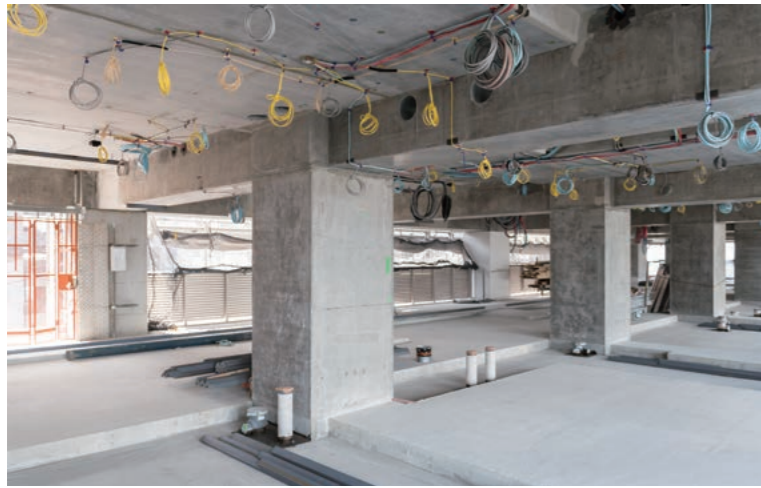
上／電気、マルチメディア、電話などの配線は用途ごとに色分けし、住戸の間取りに合わせて工場製作されたものを取り付ける。 右上／躯体工事が完了した上層階内部。柱、梁はPC工法、床はハーフPC工法。 右下／外壁にはALC版を採用。
