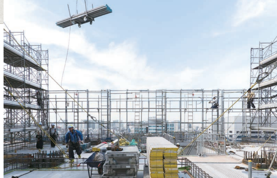
右／屋上に鉄骨造のエレベーター機械室を設置する工事が進められている。今後、太陽光発電パネルや屋上緑化が施される。 左／最上階まで躯体工事が進み、躯体外部のスライド式足場をクレーンで引き上げているところ。3.5層分の高さの足場を設け、1層分の工事が完了すると引き上げる方式。
