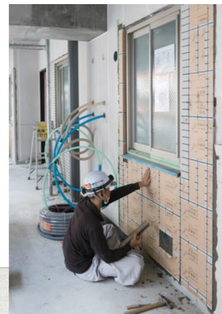
廊下側の外壁はALC版にタイル貼り仕上げ。バルコニー側の外壁は塗装仕上げが施される。
