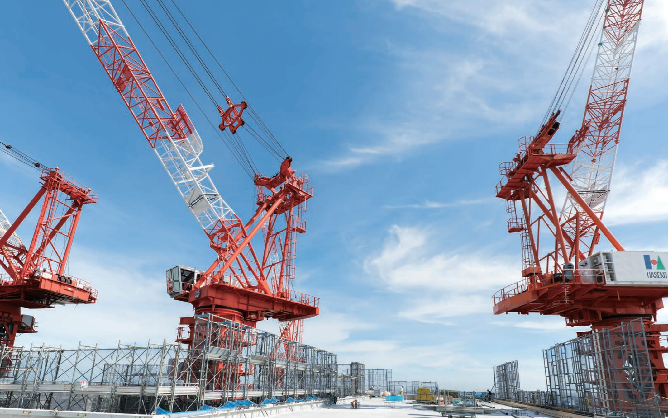
上棟したばかりの屋上階。柱、梁などの躯体工事にPC工法を採用。約3,200㎡の平面を4工区に分け、4基のタワークレーンを設置して躯体を構築してきた。クレーンは躯体工事終了後、順次撤収されていく。
