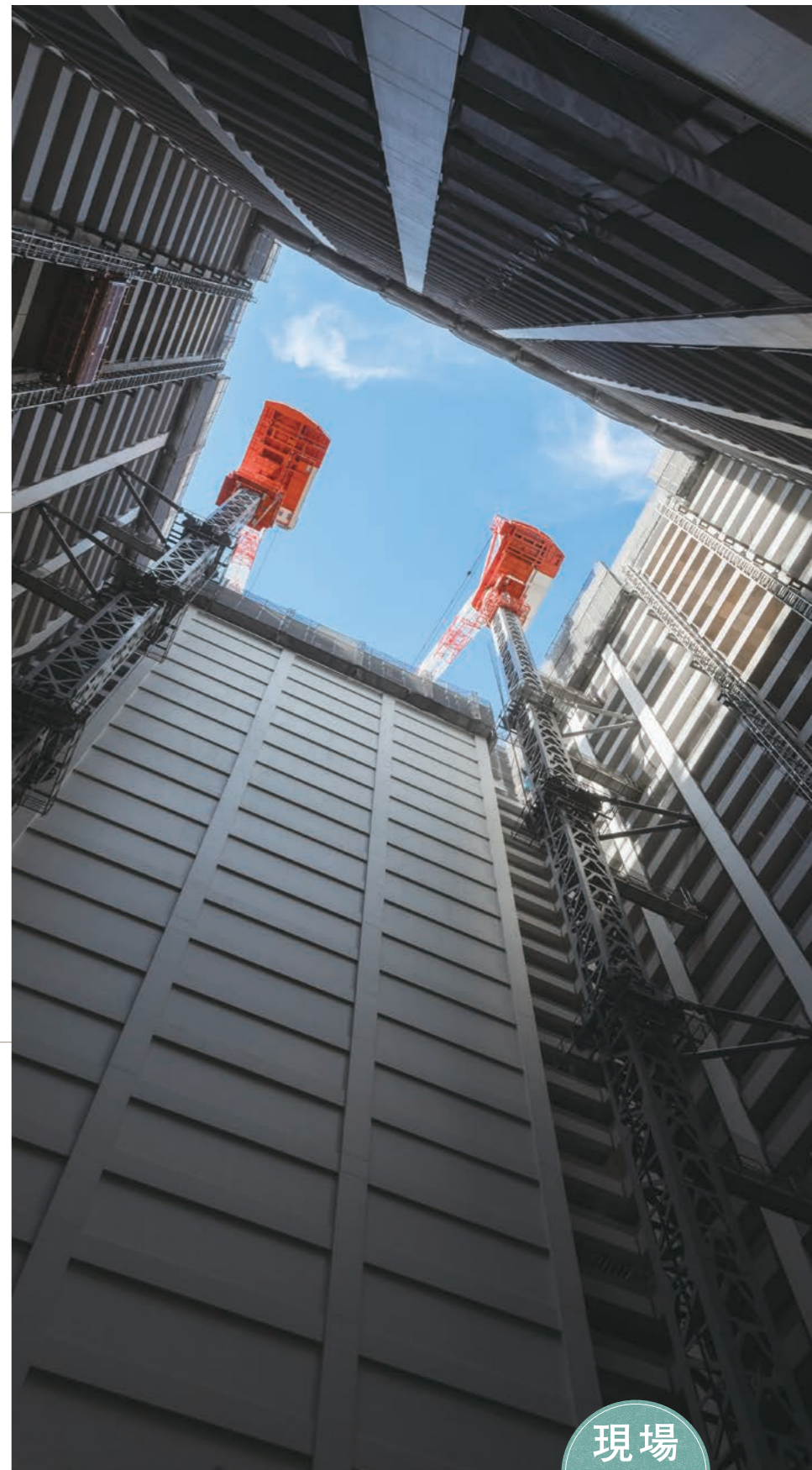
建物中央吹抜け部分のヤードから屋上まで工事が完了した吹抜けを見上げる。最上部にスライド式足場が見える。写真下側の壁面はタワー式駐車場。27階まで建物北側に一体化されている。
